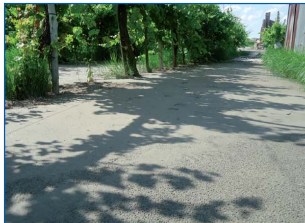
Il fenomeno della liquefazione delle sabbie a San Carlo
