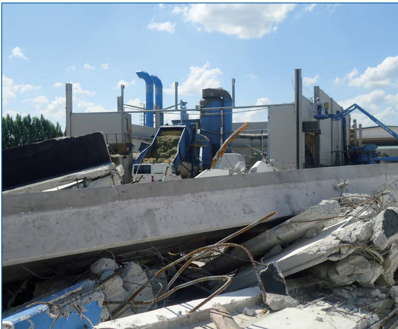
Crollo della struttura dell'impianto di essiccazione di erba medica
