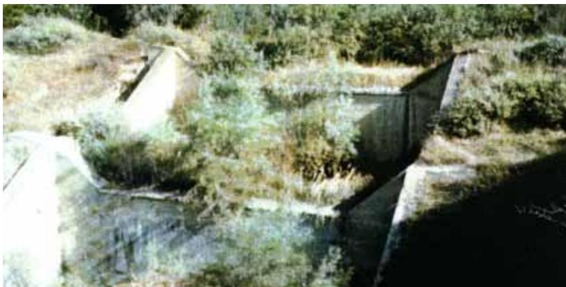
Fig. 11. La briglia a bacino sopraelevata su pali e con ali in terra del Fosso Santo Stefano, dopo essersi colmata è stata invasa dalla vegetazione spontanea che ha parzializzato la gàveta. Si osserva che le acque stanno aggirando il manufatto. L'erosione delle ali ne determina la demolizione e lo svuotamento della colmata con ripresa dell'erosione rimontante.
