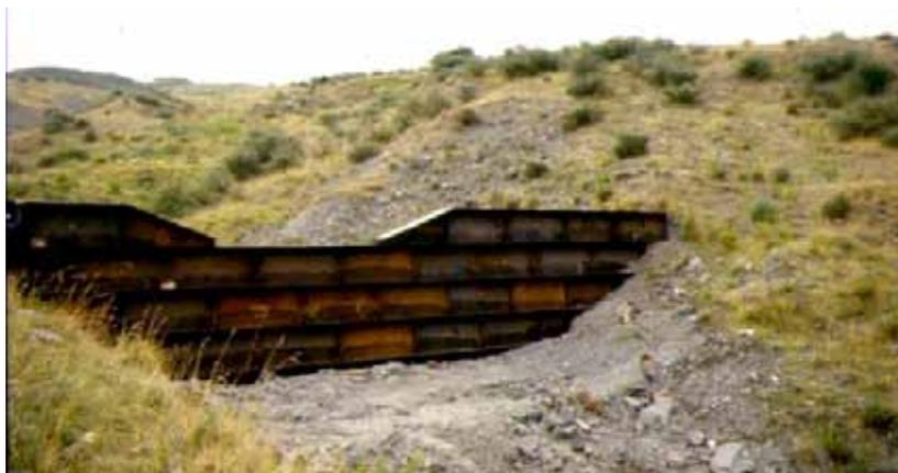
Fig. 10. Briglia autostabile prefabbricata in acciaio nel Torrente Le Canne, tributario del Camastra a Laurenzana. La parete ha posteriormente due travi di bordo laterali che mediante tiranti incernierati la collegano alla suola. Il colmamento di questa assicura l'equilibrio esterno del manufatto.
