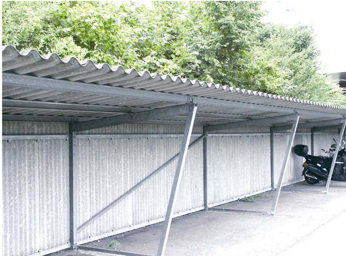
Pensilina in cemento-amianto per biciclette
