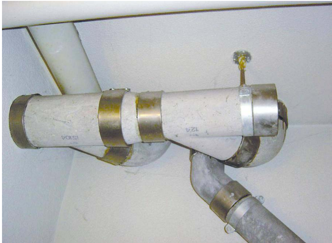
Condutture in cemento-amianto
