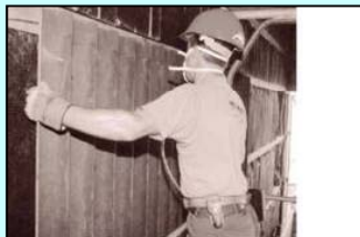
Rimozione e pulizia di lastre in fibrocemento Bollettino tecnico
