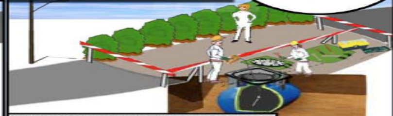
VERIFICA CON MULTIGAS E SONDA
