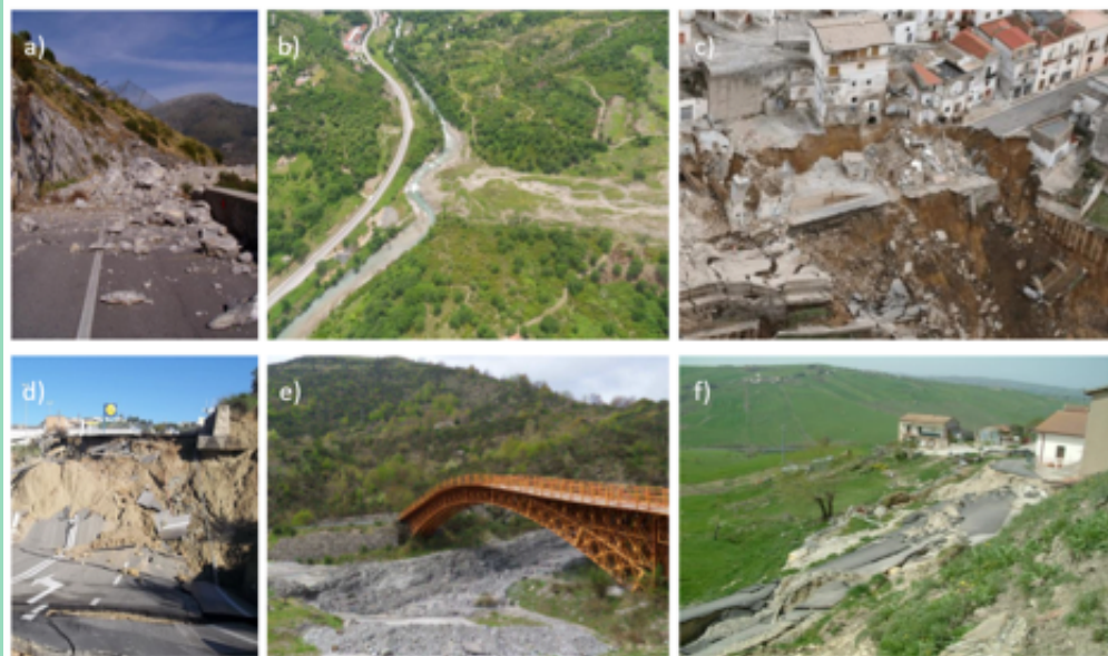
▲ Figura 2: Alcuni esempi di diverse tipologie di frane verificatesi sul territorio regionale: a) crollo (Maratea), b) colata (Trecchina), c-d-f) movimenti complessi (Pomarico, Montescaglioso, Potenza), e) debris flow (Terranova di Pollino).
